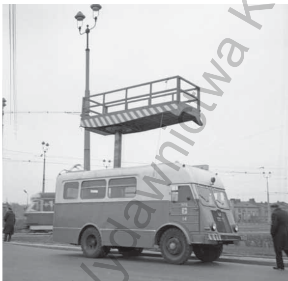
Samochód pogotowia sieciowego zbudowany na podwoziu Star 20
