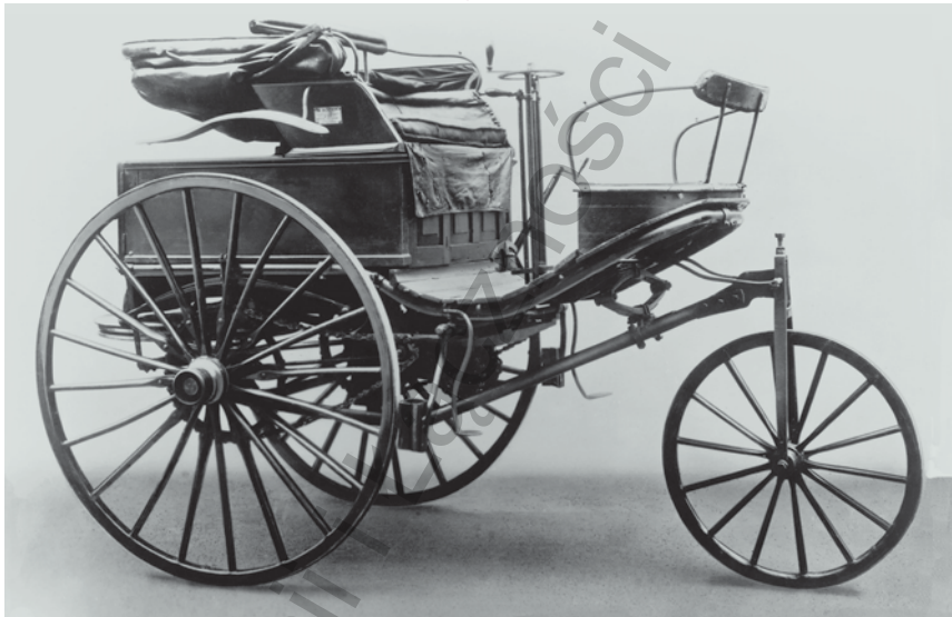
Większy, ulepszony pojazd K. Benza – Model 3 z 1888 r., napędzany silnikiem o pojemności skokowej 1660 cm 3 .
